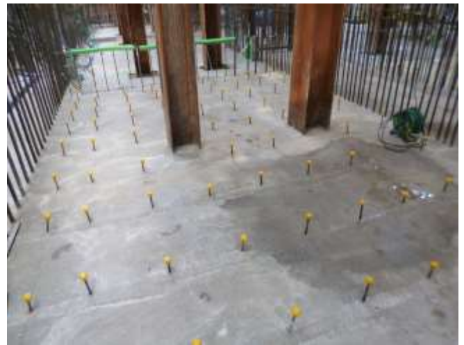
写真2：施工状況（底版）
